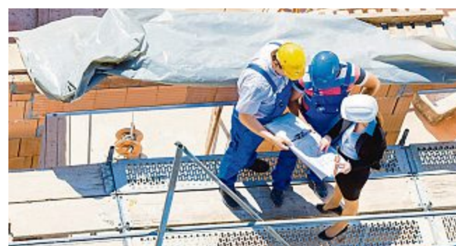
Ingenieure arbeiten in Baufirmen, Verwaltungen und Ministerien, aber auch in Forschungs- und Prüfanstalten. FOTO: PM/KZENON
