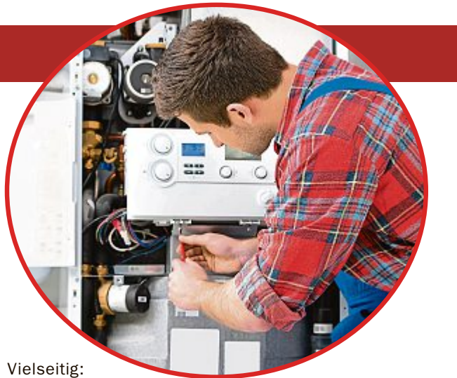
Vielseitig: das Sanitär-, Heizungs- und Klimahandwerk. Foto: PM/alextrahs
